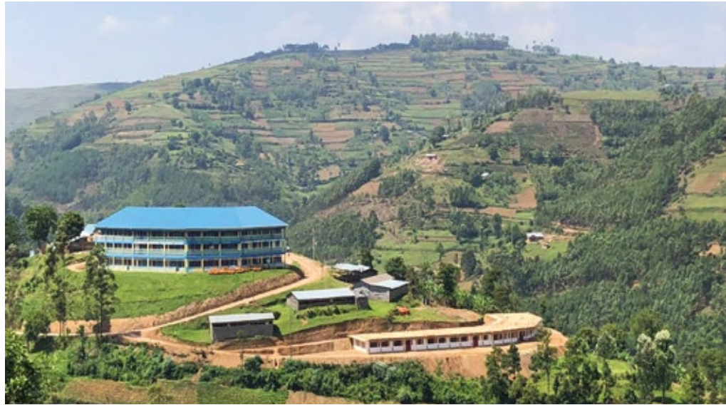
Die Bauarbeiten an der Schule sind in vollem Gange
